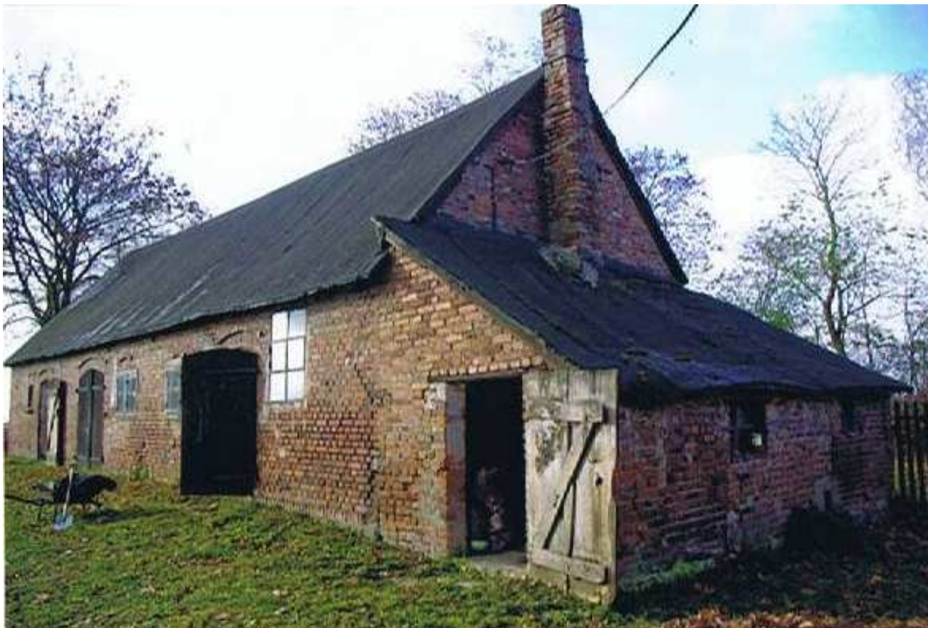
Fotografia od strony podwórza (strona południowo – wschodnia)
