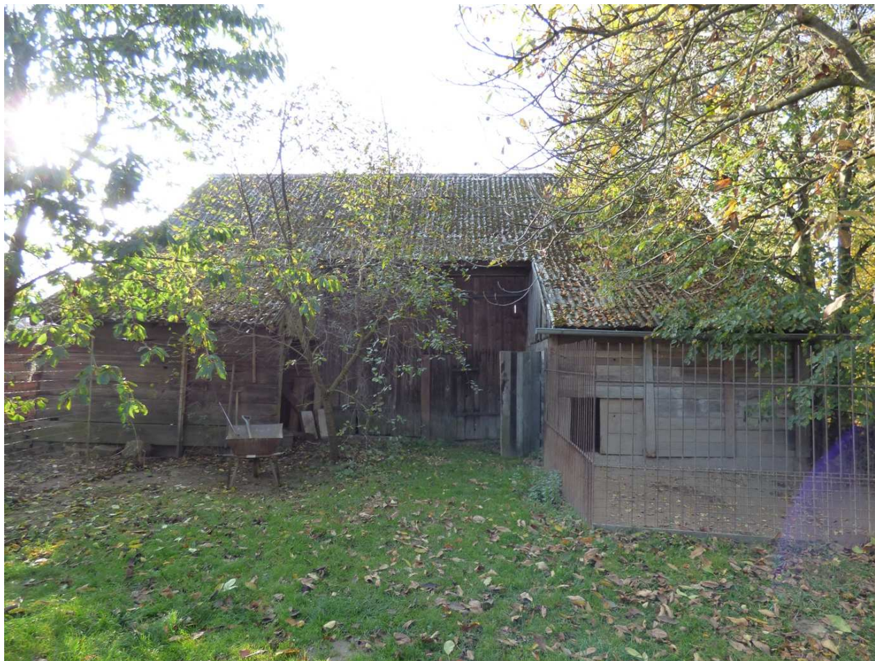
Fotografia od strony podwórza (strona północna)
