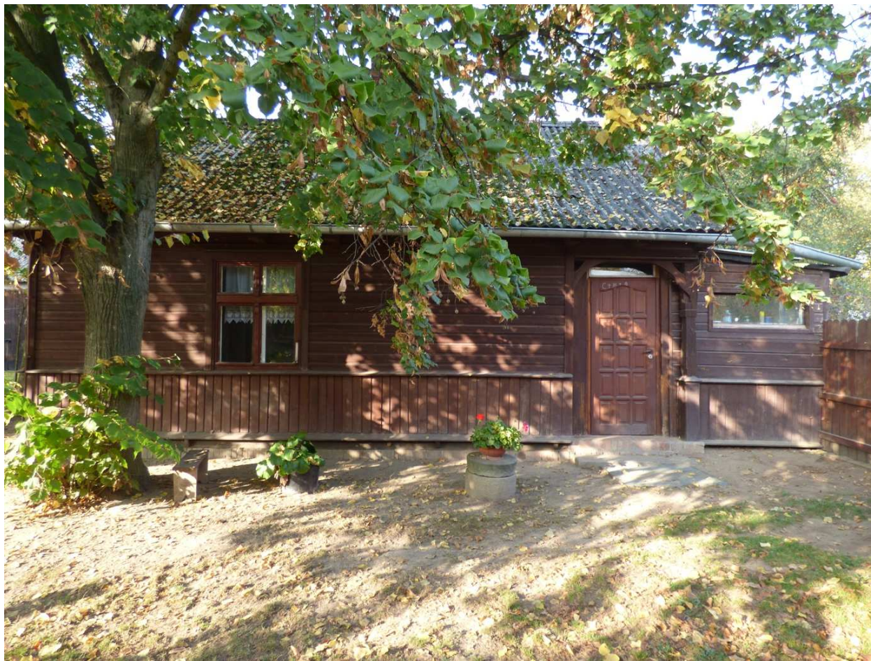
Fotografia od strony podwórza (strona południowa)
