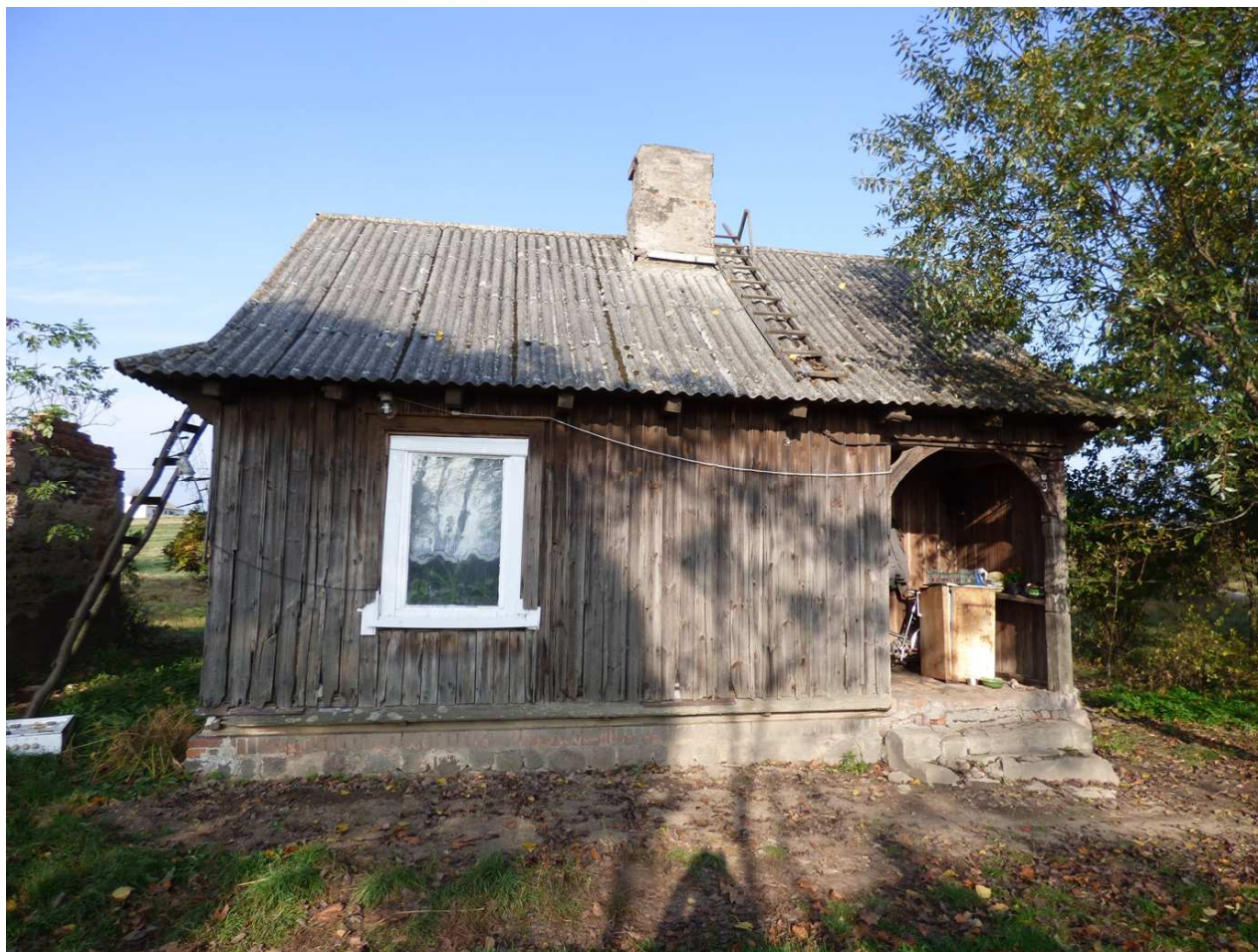
Fotografia od strony podwórza (strona południowo - zachodnia)
