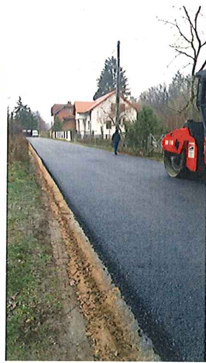
Układanie asfaltu w Drużynach
