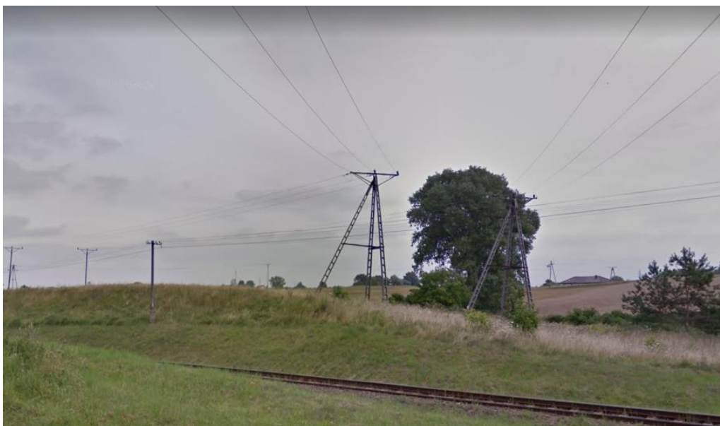
Fot. nr 1. Widok na sąsiednie tory kolejowe oraz teren objęty mpzp.
